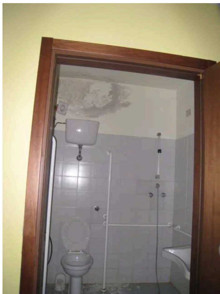
FOTO N° 21: Vista interna servizi con alcune infiltrazioni umide P.2°
